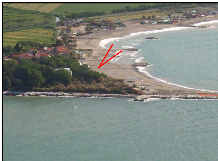
vista panoramica del contesto
